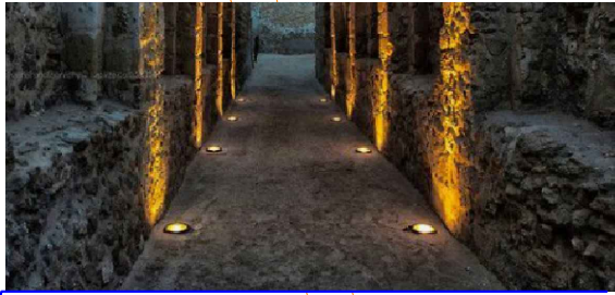
Грунтовые светильники пример подсветки каменных водных арок
